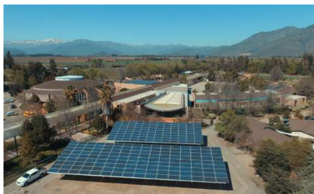
Parque paneles solares (Rising Sun - BroteCoya)
